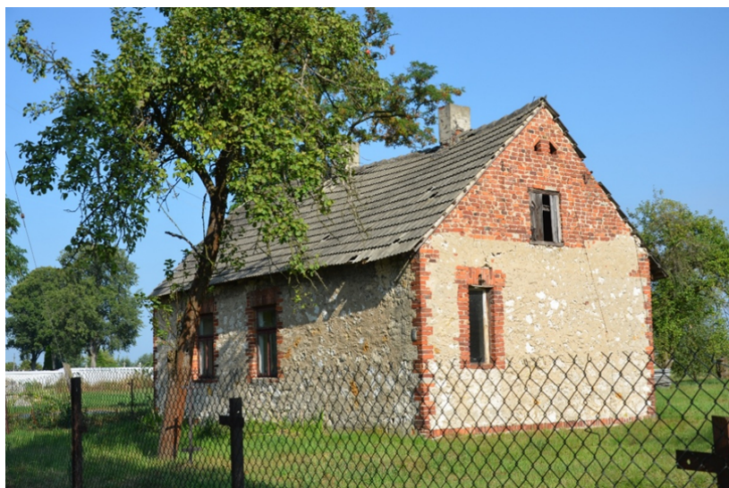
Widok na charakterystyczny dom z kamienia wapiennego – margła w miejscowości Rząśnia
